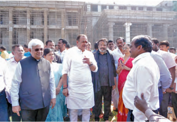
బొల్లారం టీమ్స్ ఆస్పత్రి నిర్మాణ పనులను పర్యవేక్షిస్తున్న మంత్రి కోమటిరెడ్డి వెంకటరెడ్డి, కంఠోన్మలలో ఎమ్మెల్యే శ్రీగణేష్ తదితరులు
